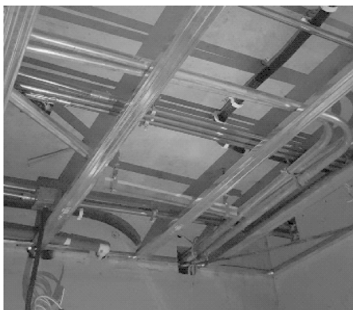
图 5.2.4 架空吊顶示意图
